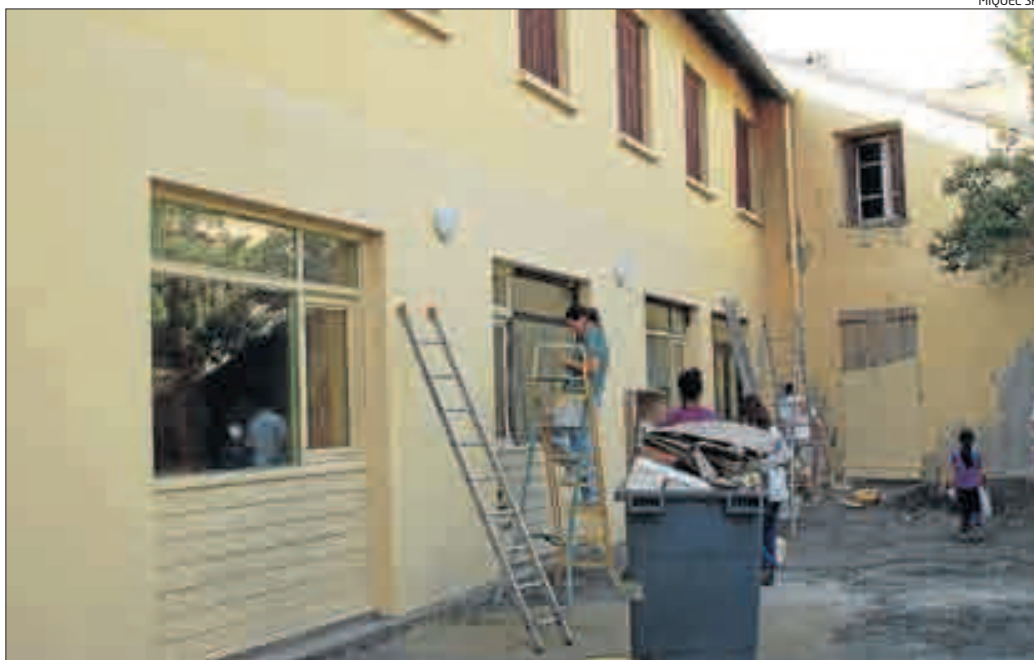
Mestres i pares pintant aquesta setmana l'edifici de la nova escola, al centre de Sallagosa
